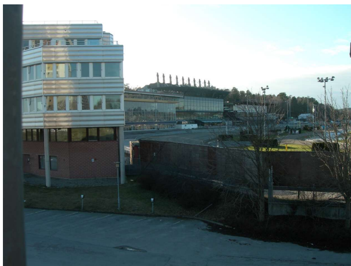
Figur 16. Utbyggnaden av Hästsportens hus idag. Arbetet med schaktning och spontning kom att utföras bara några meter från travbanan. Foto: Johan Spross.
